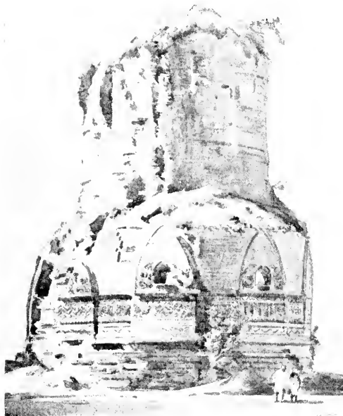
THE DHAMÉKH TOWER
